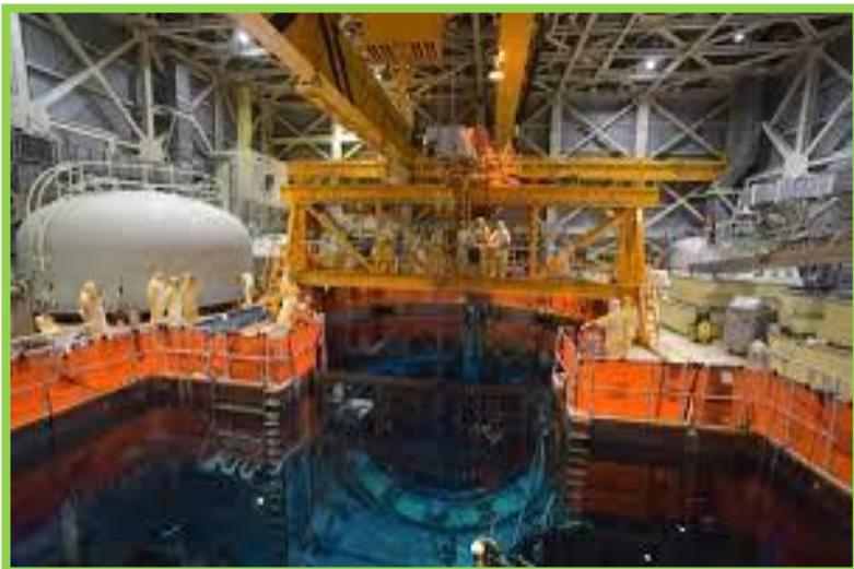
Espacio en el edificio del reactor, que tiene como objetivo y función **almacenar el combustible irradiado** producto de la operación en el reactor.
