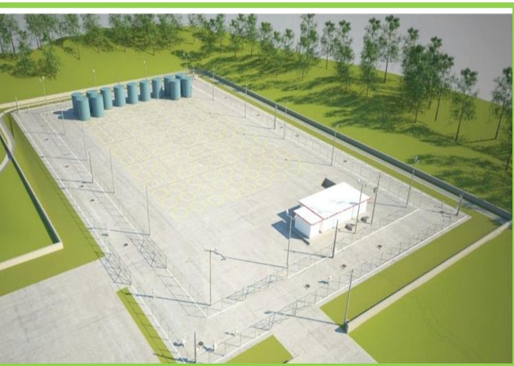
Instalación dentro del perímetro de la CNLV, que tiene como objetivo y función **almacenar en seco el combustible irradiado**, en contenedores en un almacén a cielo abierto.
