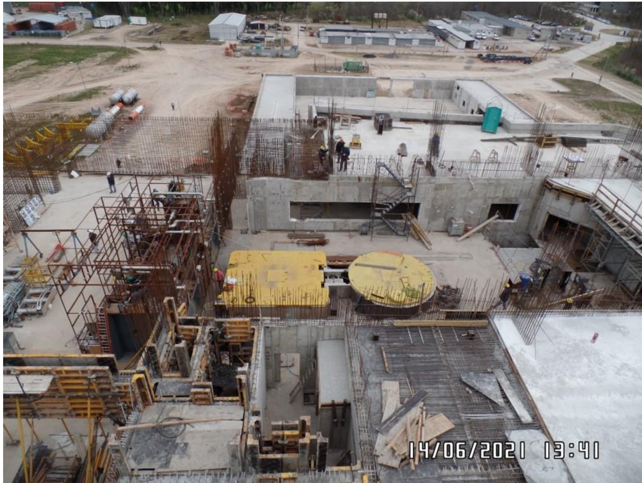
Avance de obra. Junio 2021
