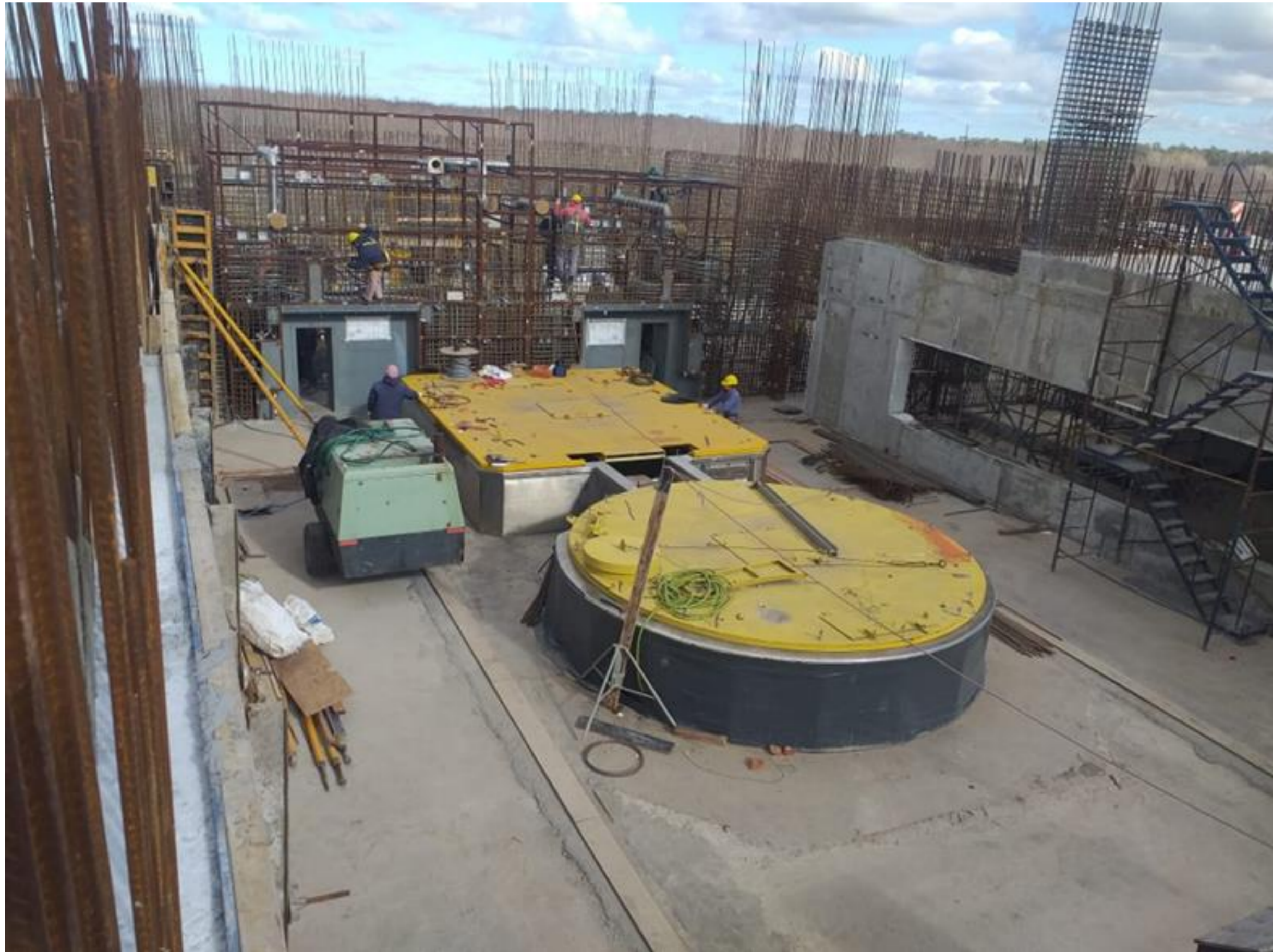
Avance de obra. Junio 2021
