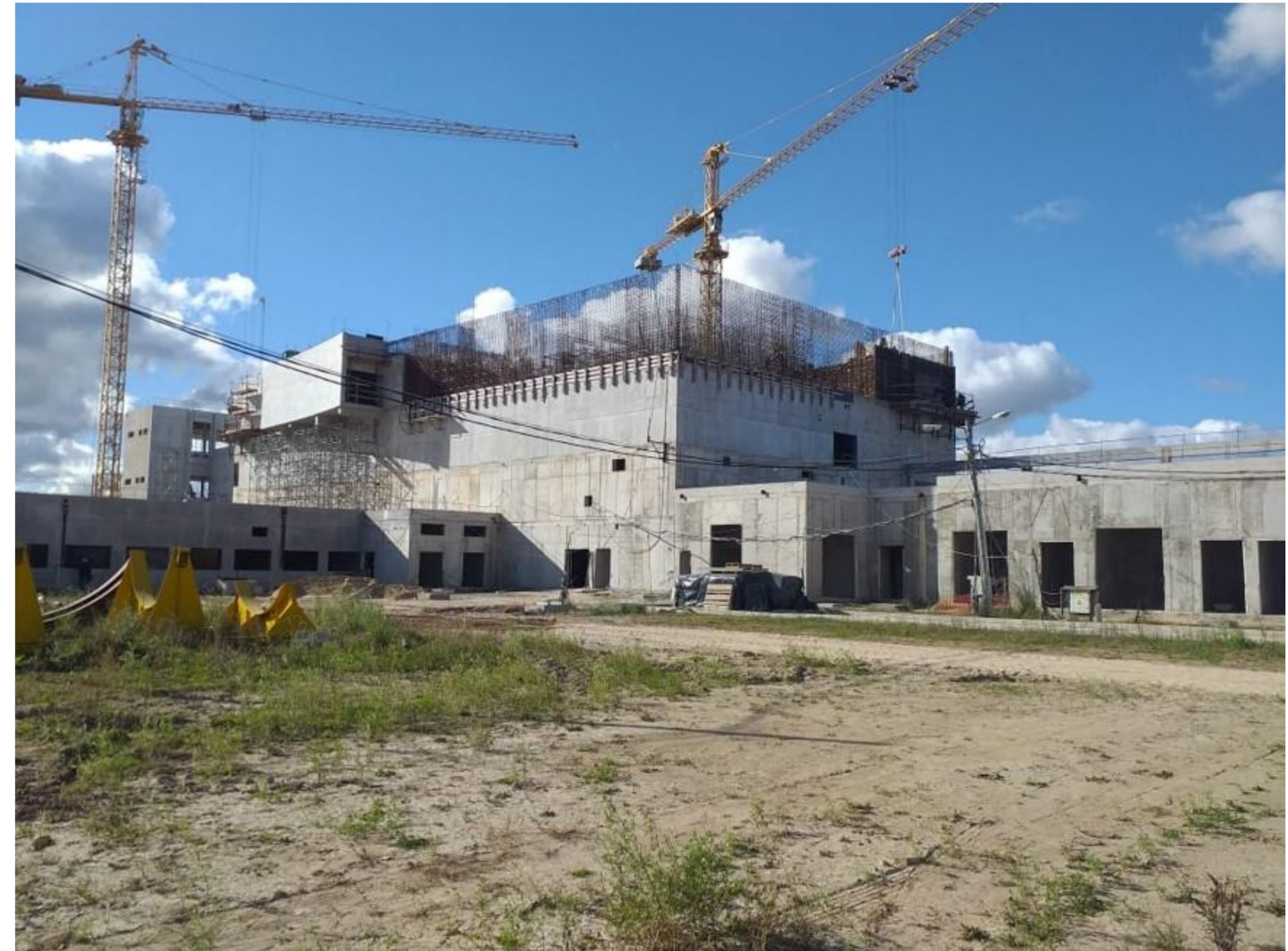
Avance de obra. Junio 2021
