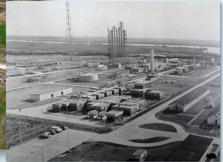
Sitio de emplazamiento de la ex Planta Experimental de Agua Pesada (PEAP) - '70 / '80s (Desmantelada entre 1998 y 2003)
