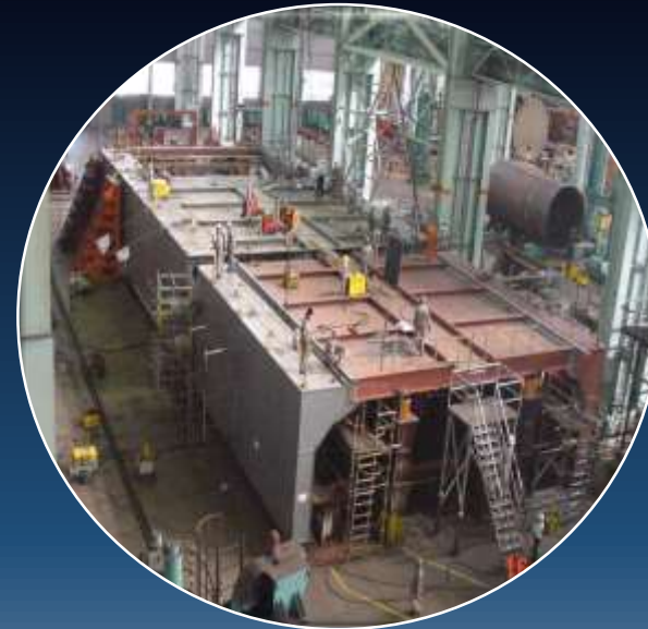
Vigas Cantilever - PETROBRAS P-3
