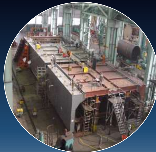
Vigas Cantilever - PETROBRAS P-3
