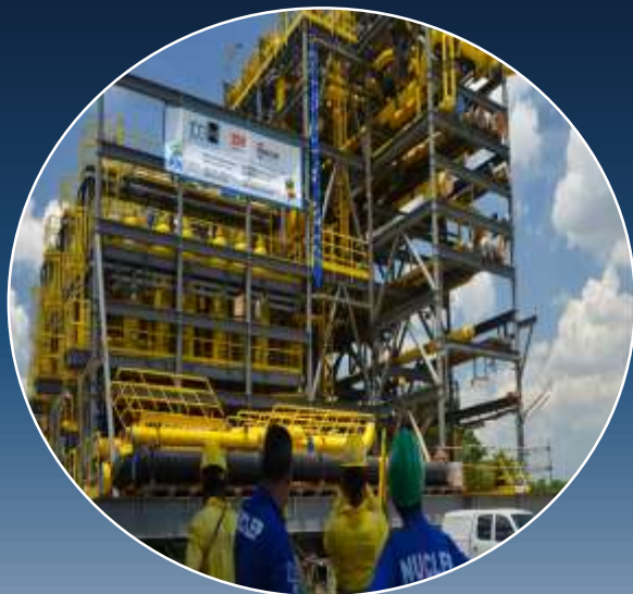
Módulos para FPSO
