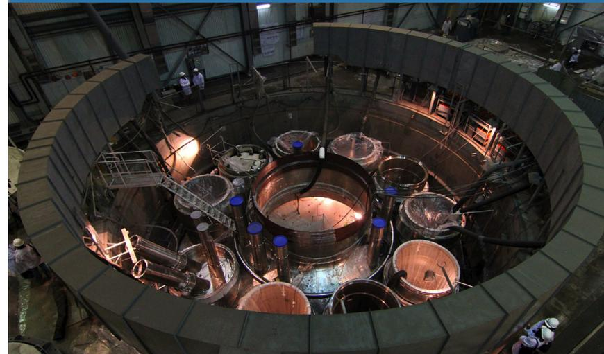
O reator BN-800 é um reator regenerador rápido refrigerado a sódio. Projetado para gerar energia elétrica total de 880 MW, a planta é a etapa final do ciclo comercial de reatores de neutrons rápidos. A planta começou a produzir eletricidade em 10 de dezembro de 2015, com um consumo reduzido de energia de 235 MW.
