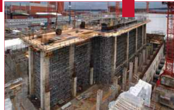
Prédio da turbina
