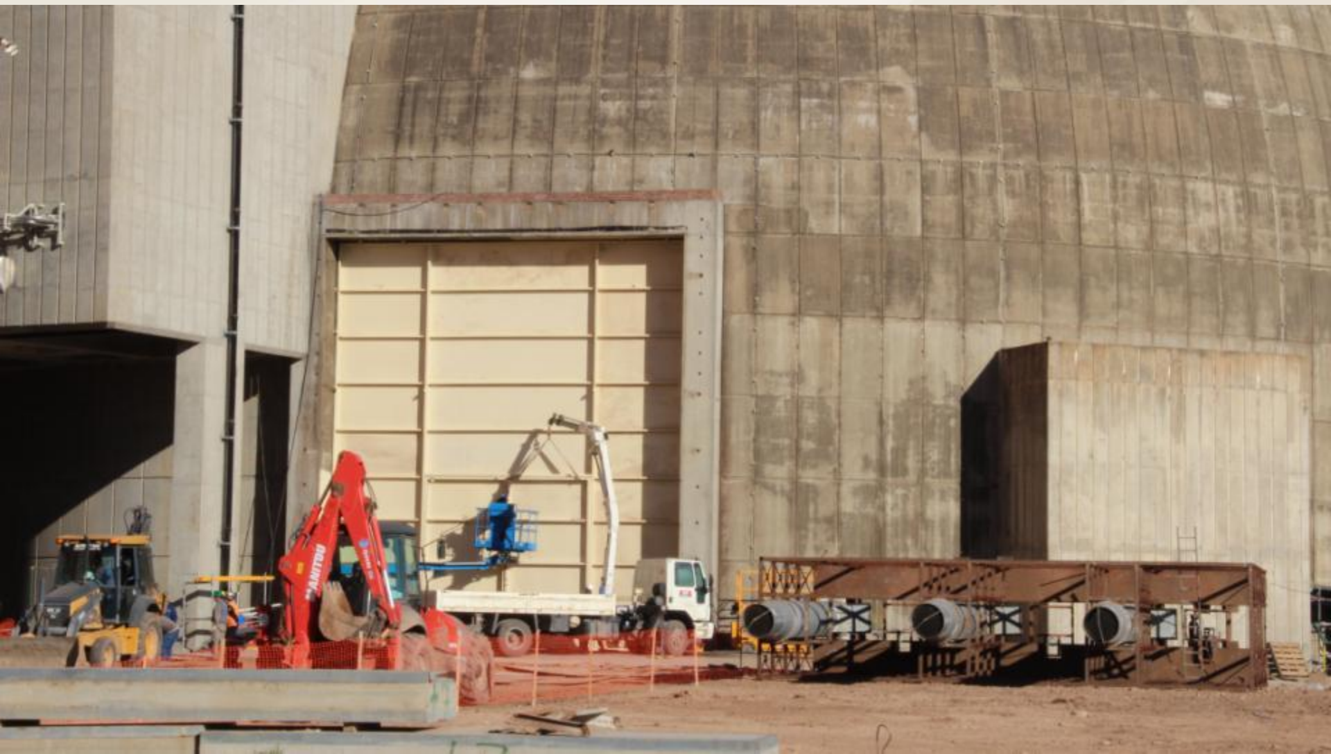
Cierre abertura de montajes edificio del Reactor
