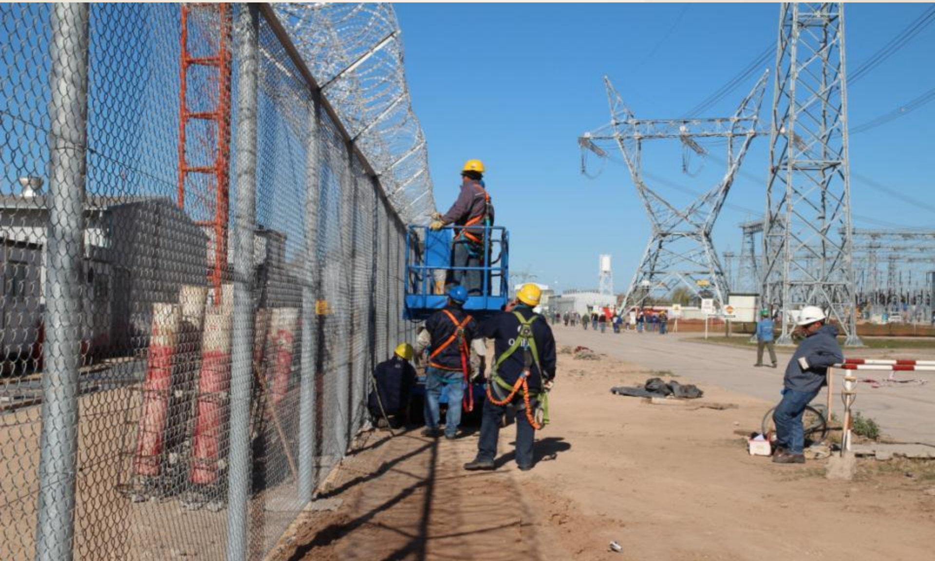
Colocación cerco perimetral para protección física
