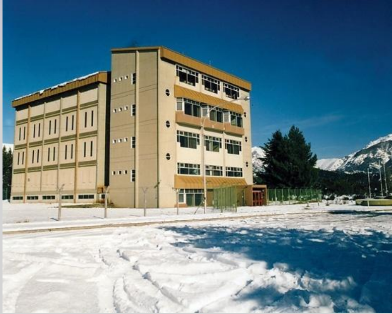
Edificio Reactor RA-6
