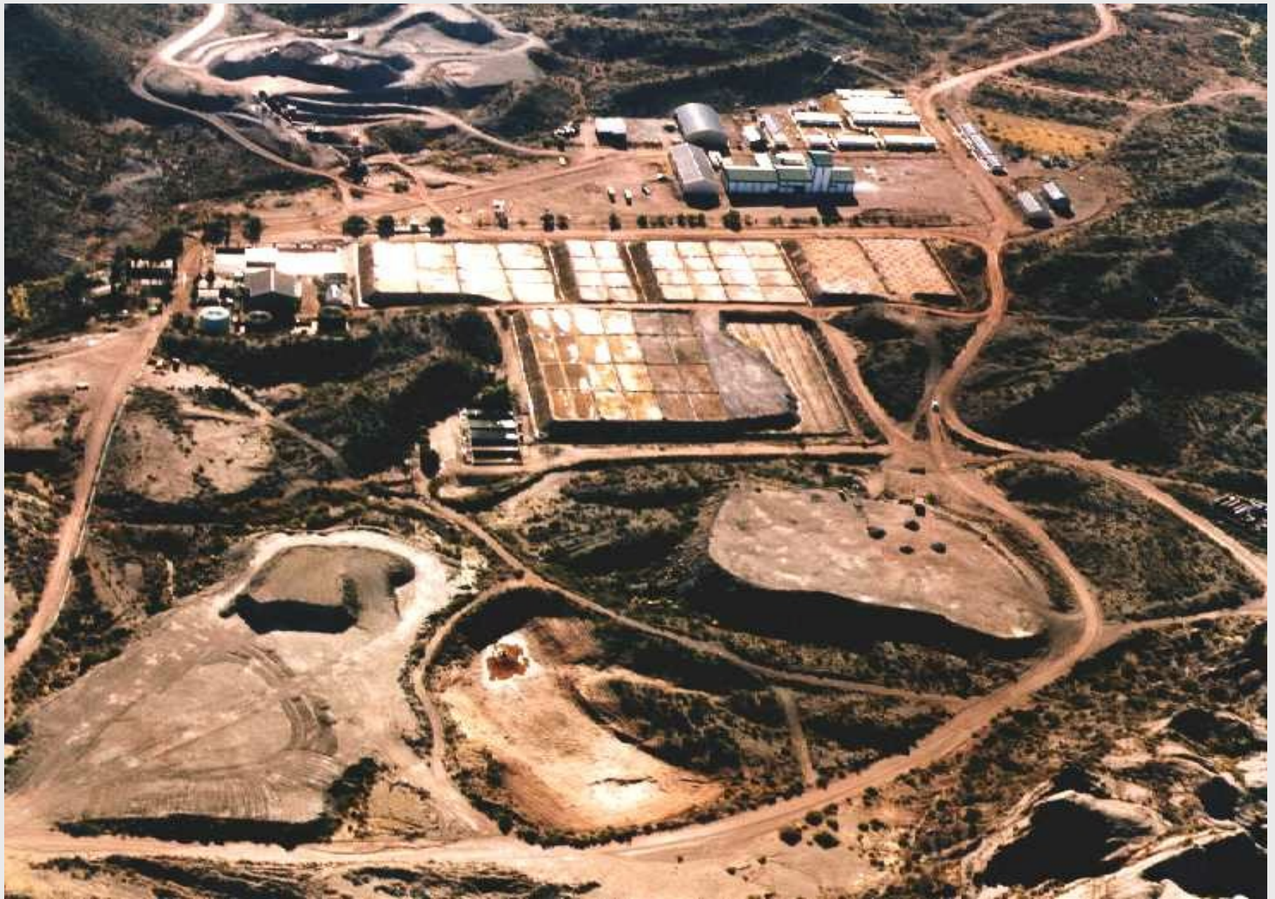
PILAS DE LIXIVIACION
