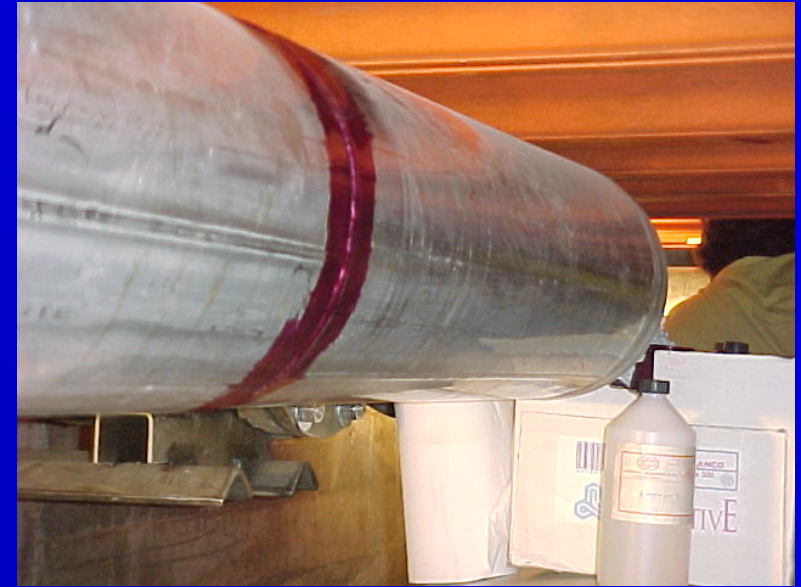
Inspección con líquidos penetrantes
