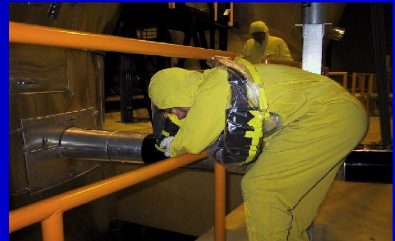
Termografía infrarroja en la Central Nuclear Atucha
