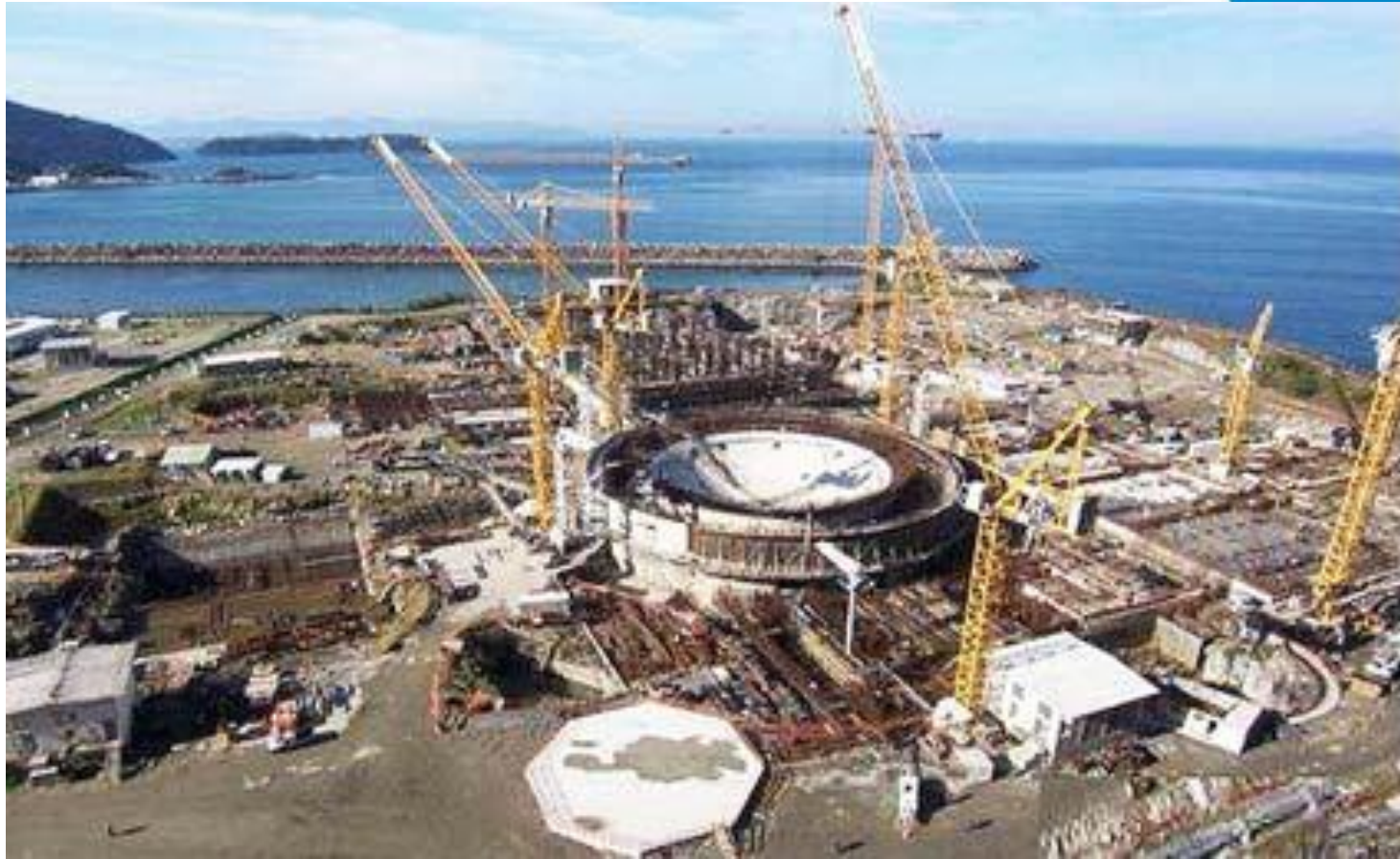
Angra 3 – status de construção do Edifício do Reator
